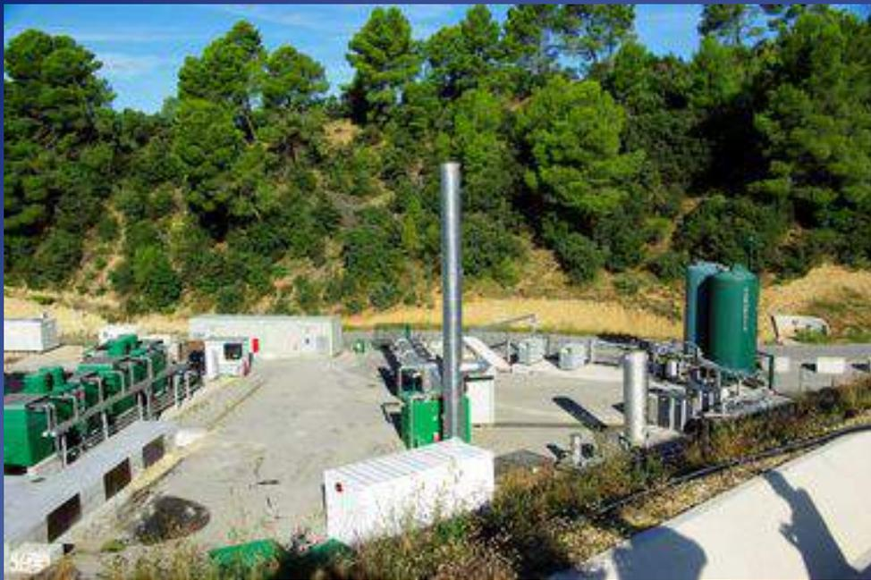
**Une unité de valorisation des biogaz en énergie électrique, pour alimenter l'unité de filtration des lixiviats par « osmose inverse ».**
