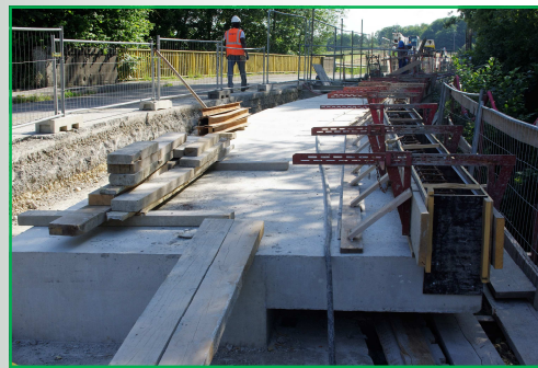
64 Micro-pieux enfoncés à 17 m pour stabiliser
