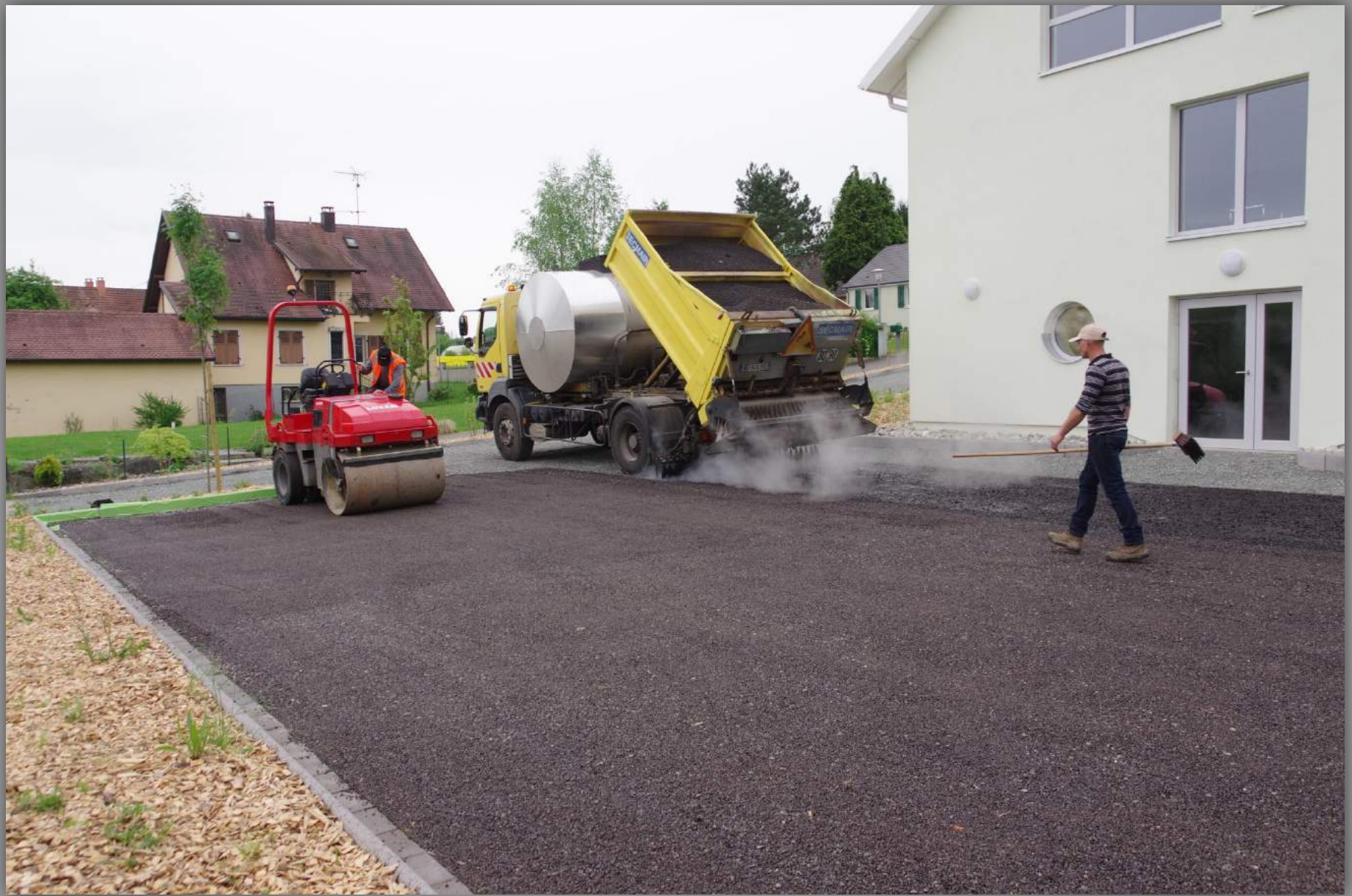
Revêtement macadam recyclé: Parking accès mairie-chemin de l'AMAP- reprises diverses 6800 €
